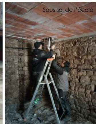
Tuyau d'évacuation de la fumée dans la classe du Directeur
